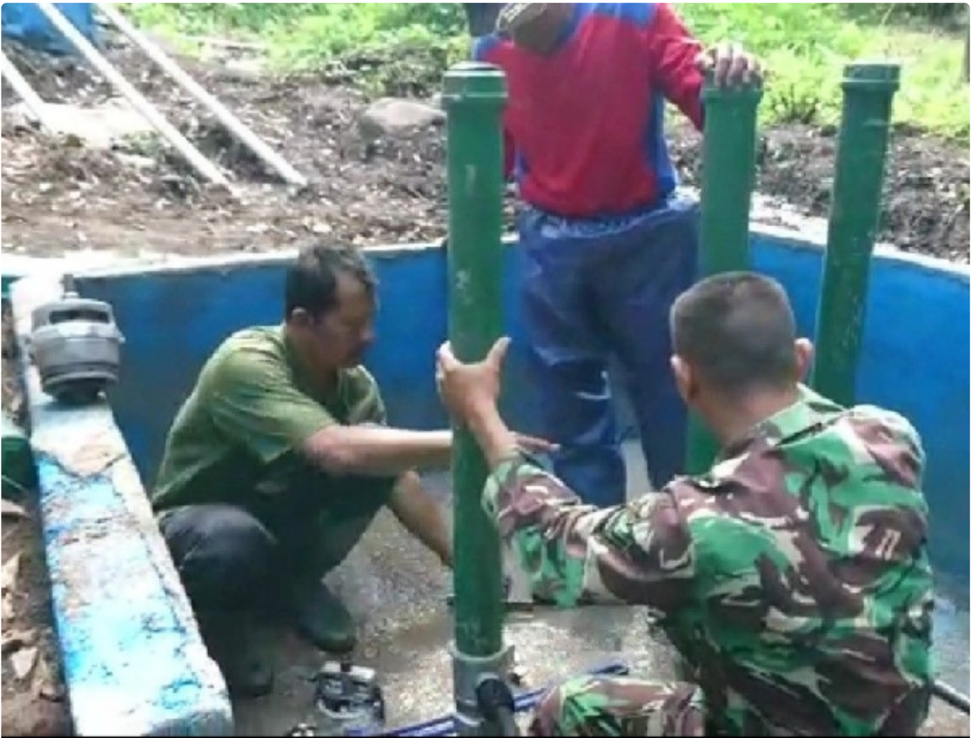
Babinsa Koramil Banjar melaksanakan pemeliharaan pompa hidram, pastikan berfungsi dengan baik
