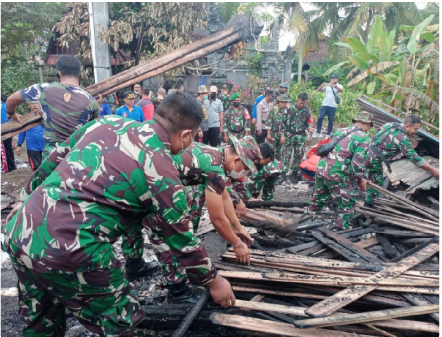
Bersihkan sisa puing-puing bekas kebakaran
